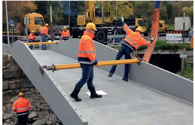
Brücke aus Carbonbeton
