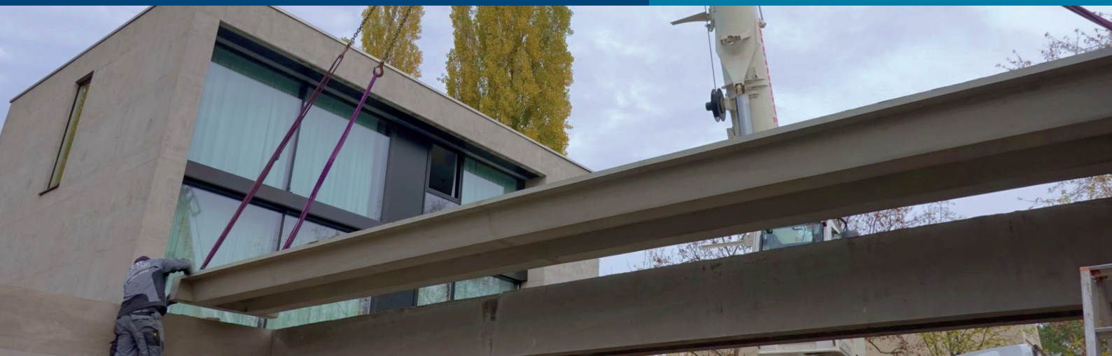
Montage einer Trapezplatte aus vorgespanntem Carbonbeton für eine Garage
