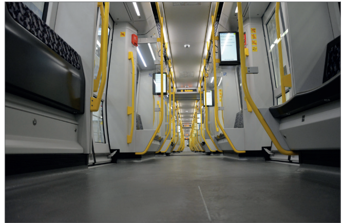
U-Bahn mit Bodenplatte aus Schaumkern
